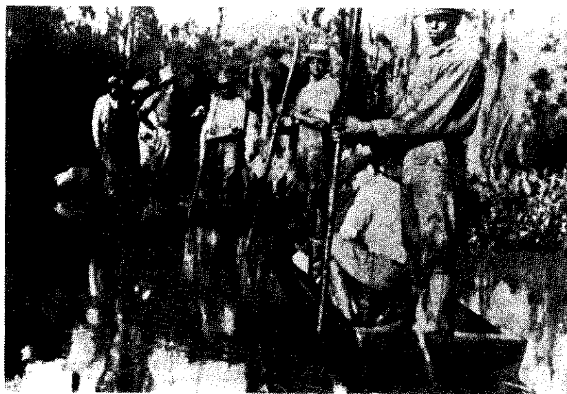
Рис. 1.17. Фотографии, полученные в процессе проведения первых работ по методу преломленных волн [144]. a — Д. Петти рассматривает запись преломленных волн в районе болота Чакахула; сейсмоприемник находится на кипарисовом пне на заднем плане. б — Петти (в лодке) со своим отрядом на болоте Чакахула.
